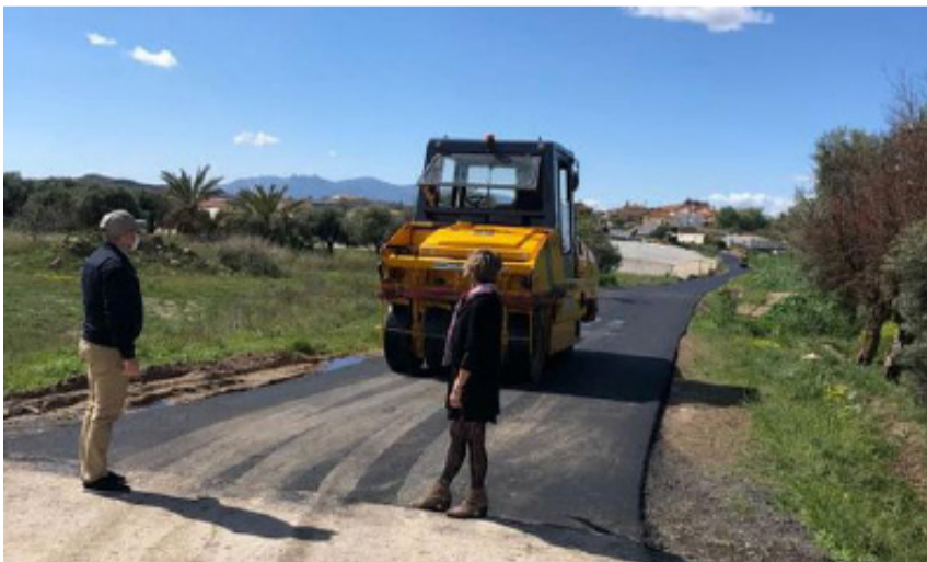
Los ediles comprobando el asfaltado del camino.
